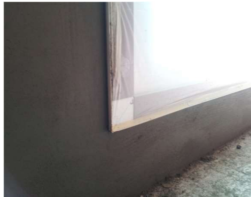
▲ 미장 작업 후
