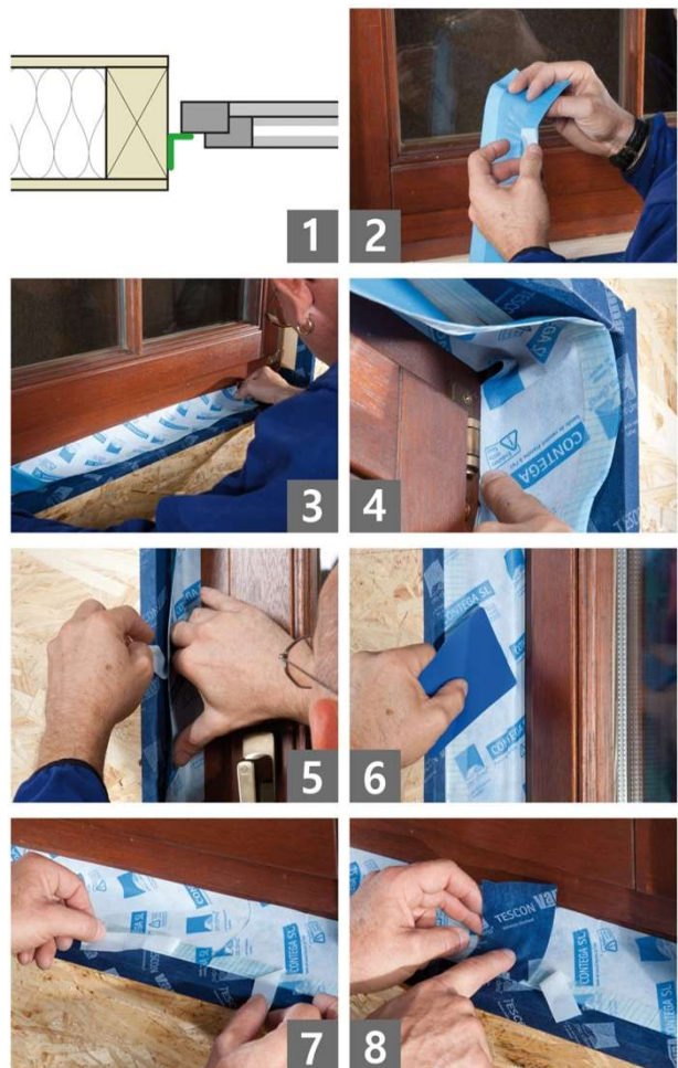
목재, 창호 시공 후
