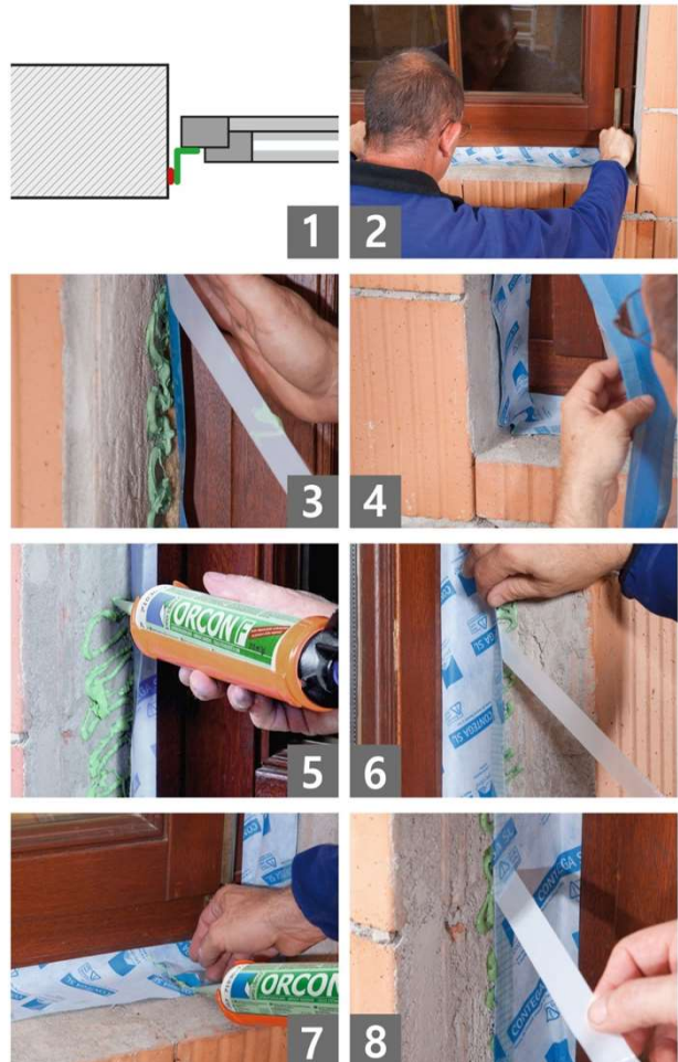
rc 창호 시공 후
